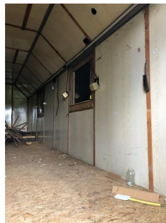
Uwe Kersten wird für die Elektrik im Bauwagen sorgen
